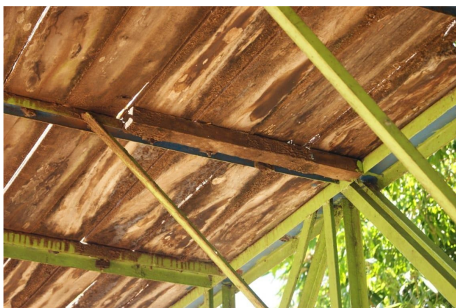
Figura 1 – Peça de madeira como reforço
