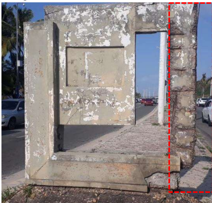
Figura 1 – Ornatos de Concreto Armado
