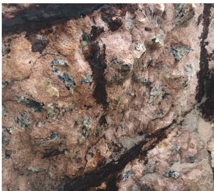
Figura 2 – Estrutura após aplicação de fenolftaleína 1%
